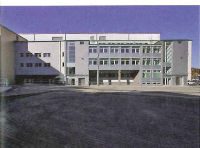
Das neue Produktionsgebäude in Gornsdorf
